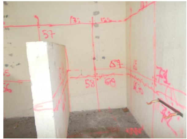
Mur gauche de la pièce n°1 du bâtiment AT17 n°4
