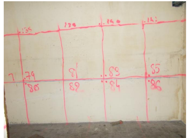
Mur gauche de la pièce n°2 du bâtiment AT17
