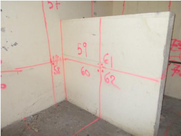
Mur gauche de la pièce n°1 du bâtiment AT17 n°3
