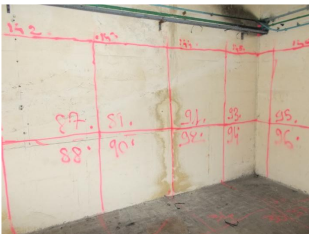
Mur fond de la pièce n°2 du bâtiment AT17
