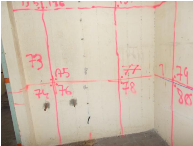
Mur entrée gauche de la pièce n°2 du bâtiment AT17
