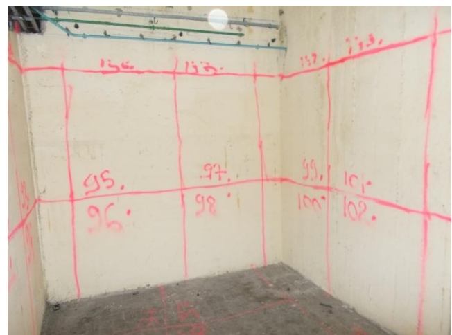
Mur droit et mur entrée droit de la pièce n°2 du bâtiment AT17
