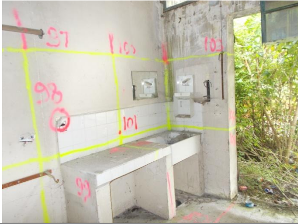
Entrée et mur droit du bâtiment AT16
