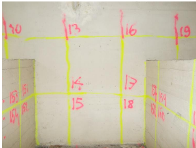
Mur gauche principal et 2 murets
