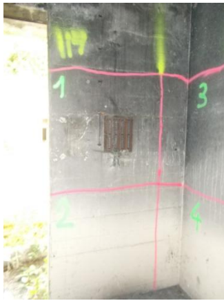
Mur entrée droit du bâtiment AT14
