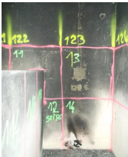
Mur gauche bâtiment AT14 n°2
