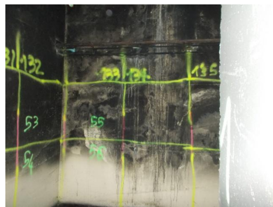
Mur fond et mur droit pièce n°2 du bâtiment AT14
