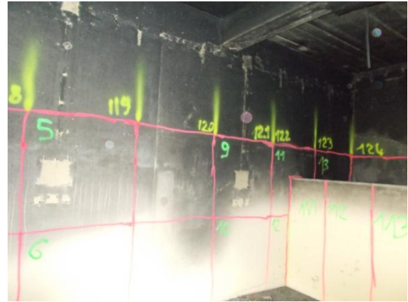
Mur gauche bâtiment AT14 n°1
