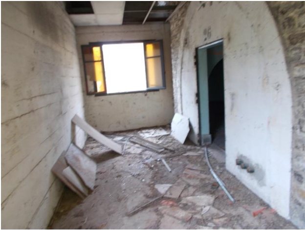
Entrée du bâtiment 26
