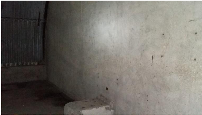
Mur fond du bâtiment LG3
