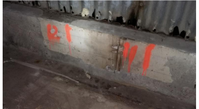
Muret gauche du bâtiment LG3
