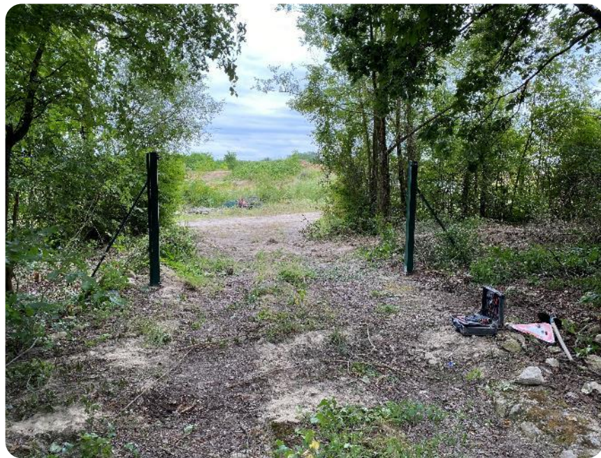
Retrait de la clôture au niveau de l'ancienne entrée sud
