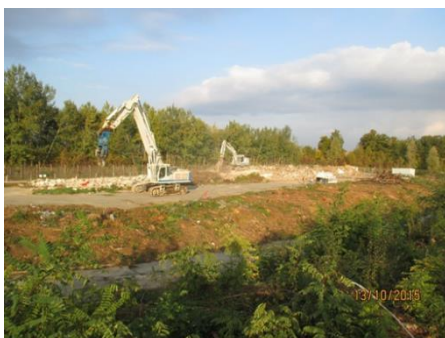
Bâtiment MP : Après démolition
