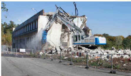
Bâtiment MP : En cours de démolition Pelle équipée de brumisation
