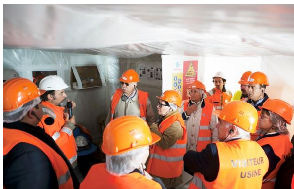
Le désamiantage des bâtiments
