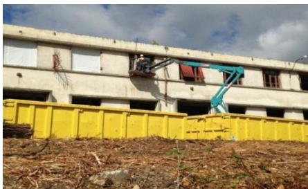
Bâtiment MP : Confinement avant désamiantage
