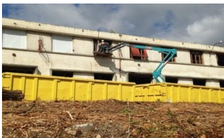
Bâtiment MP : Confinement avant désamiantage
