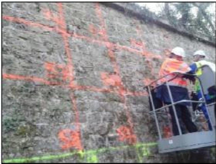
Mur dans les douves en face de LG2
