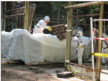
Bâtiment F : Démontage des bardages en fibro-ciment
