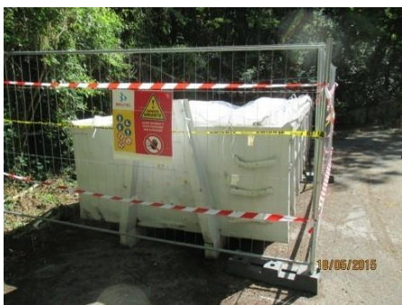
Bâtiment 28 : Benne de déchets amiantés
