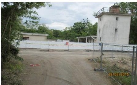
Bâtiment PGO : Balisage du périmètre d'intervention
