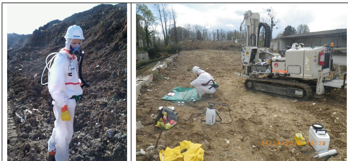
Figure 21 : Prises de vue du chantier de sondages
