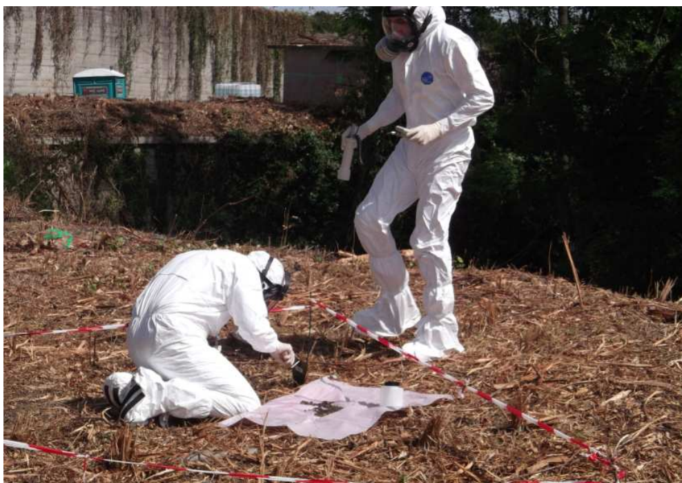
Figure 10 : opération de retrait de paratonnerre sur la zone A4-A8 (maille 29)
