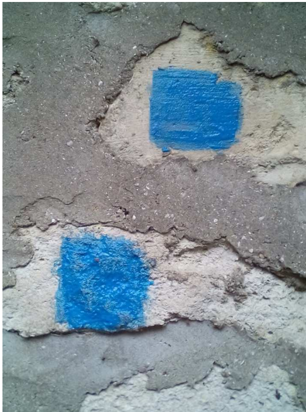
Figure 3: Pose de fixateur (film pelable)
