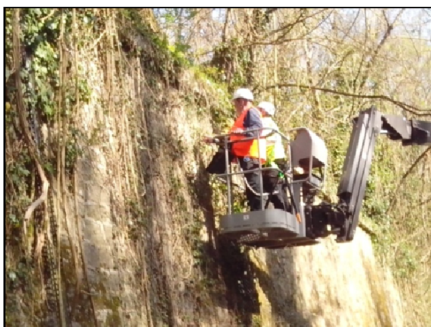
Figure 4 : Elagage sur le mur des douves-LG2 puis maillage et contrôles
