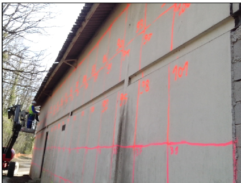
Figure 19 : Bâtiment SI mur
