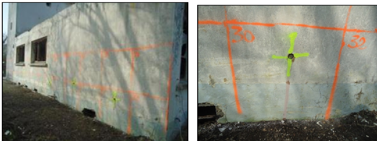
Figure 18 : Bâtiment PGO mur
