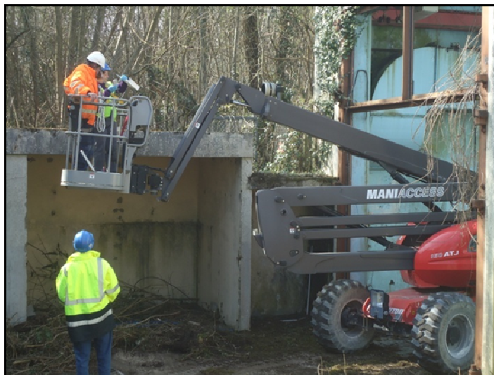
Figure 8 : Contrôle sur toiture à partir d'une nacelle
