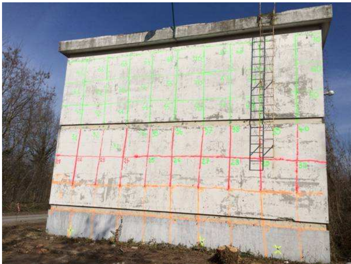
Figure 11 : Bâtiment DTE mur
