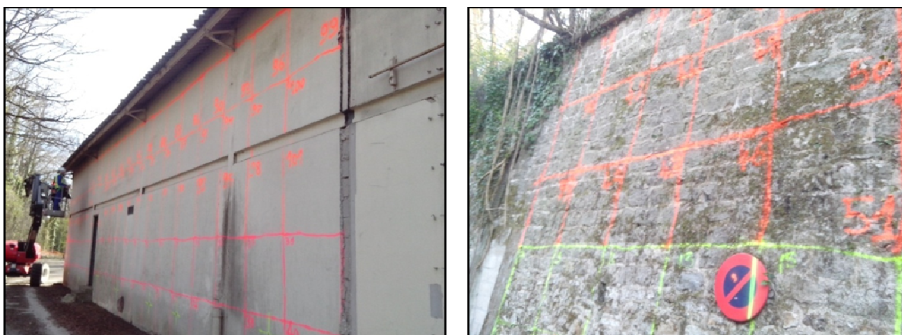
Figure 6 : Exemple de maillage sur les murs
