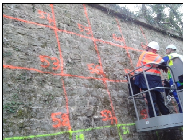
Figure 4 : Elagage sur le mur des douves-LG2 puis maillage et contrôles
