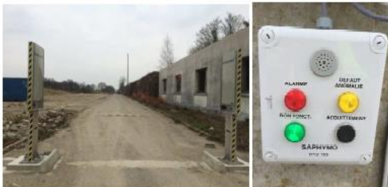
Figure 1 : Portique de détection de radioactivité (à gauche les détecteurs, à droite, le boîtier)
