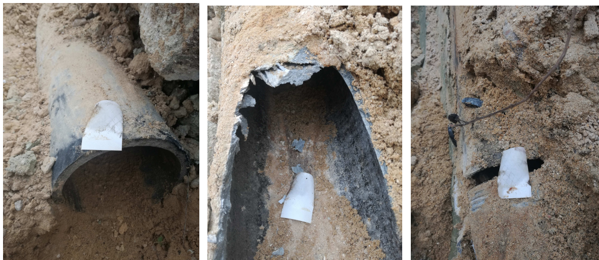
Test EXPRAY en condition amiante
