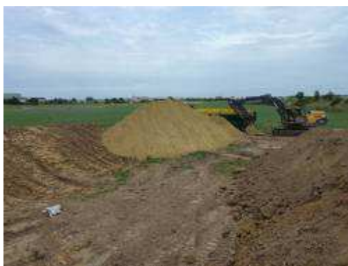
Préparation d'un camouflet d'une bombe de 500lb
