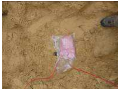
Double amorçage par cordeau détonant
