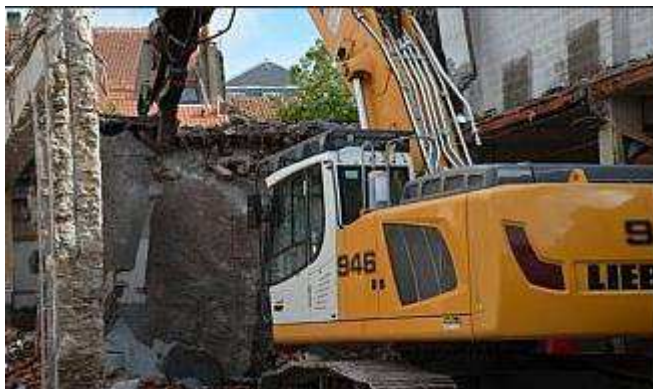
Exemple de déconstruction par grignotage
