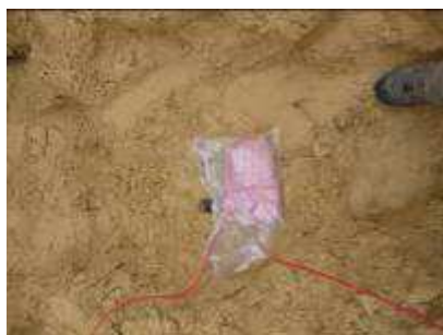
Double amorçage par cordeau détonant
